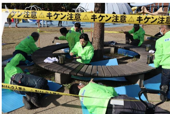
塗装作業風景
