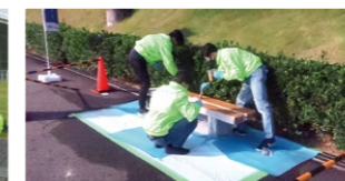
塗装作業風景
