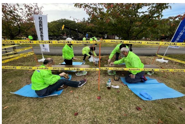
塗装作業風景
