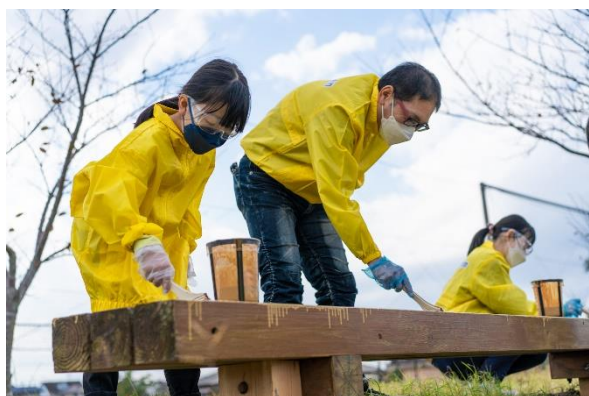
塗装作業風景
